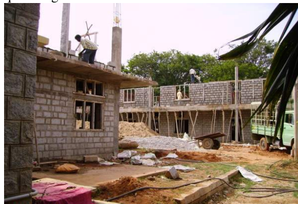
Nella foto, la costruzione del nuovo reparto disabili.
